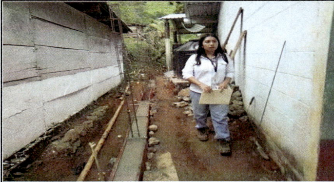
Foto 7: Reparación de muro perimetral área norte del establecimiento.
