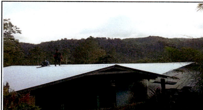
Foto 2: Instalación de láminas troqueladas del módulo No. 2.
