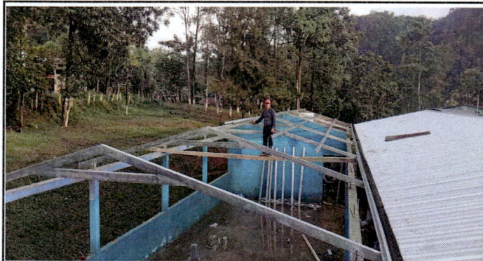
Foto 1: Instalación de estructura de techo módulo No. 2.
