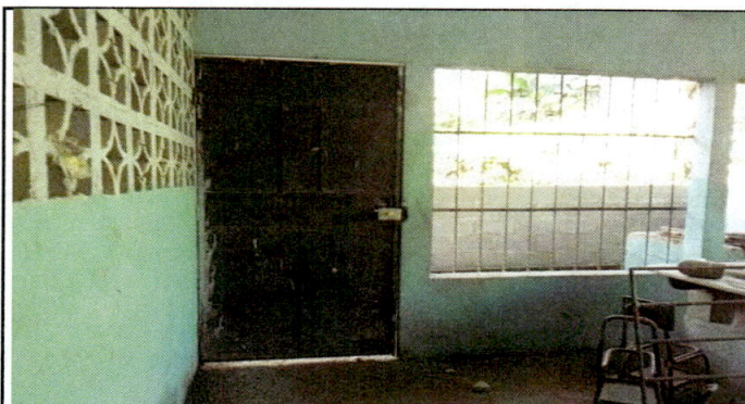
Foto 4: Instalación de chapa para puerta de metal al fondo del módulo No. 02.
