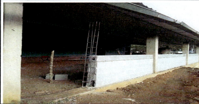
Foto 11: Reparación de barandas del corredor del módulo No. 01.
