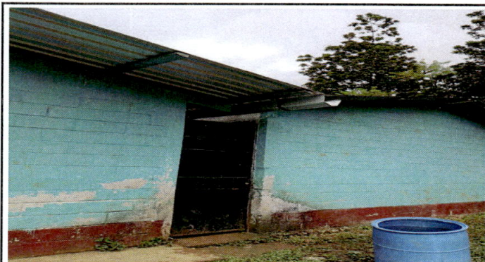
Foto 3: Instalación de puerta de metal con chapa de la entrada principal del módulo No. 02.
