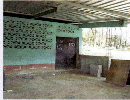
Foto 8: Instalación de chapa para puerta de metal de la Dirección del módulo No. 01.
