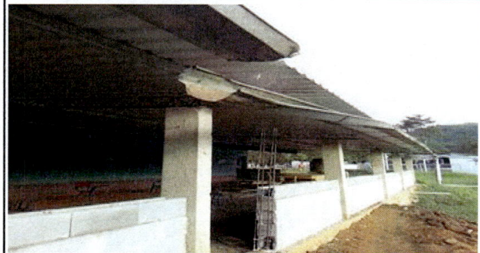
Foto 10: Reparación de canal del corredor del módulo No. 1.
